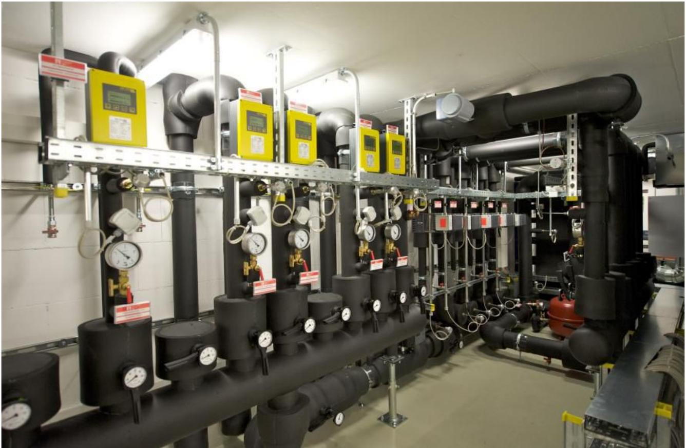
Die Versorgungsanlage Umluft und Kühlung im Data Center.
