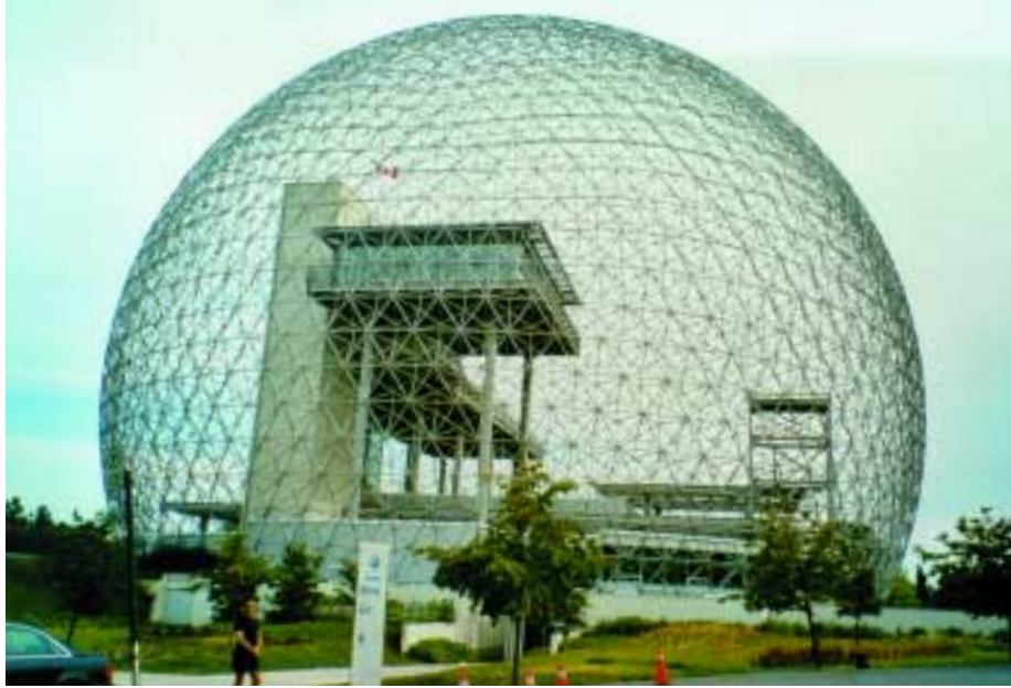
Abbildung 1: Geodätischer Dom mit 76 m Durchmesser, erbaut als amerikanischer Pavillon für die Weltausstellung 1967 in Montreal
